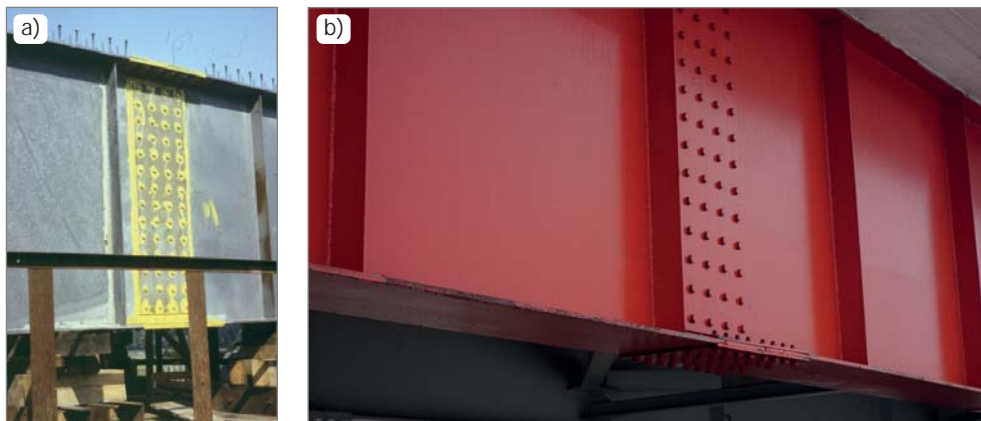
Rys. 2.68. Przykład doszczelnienia połączeń na śruby sprężające dźwigarów głównych mostu przez Odrę w Cigacicach. Widoczny kontrastowy kolor materiału doszczelniającego poszczególne wolne przestrzenie nakładek w obrębie otworów (po lewej). Na zdjęciu po prawej widoczne połączenie po 4 dekadach eksploatacji
